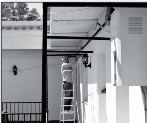
1. instalación eléctrica de la parte superior
