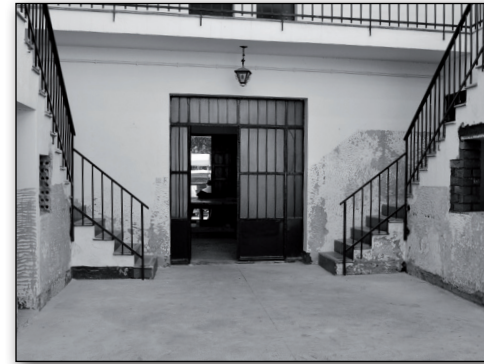
2 Alicatado, Puerta del fogón y cocina del H.M.
